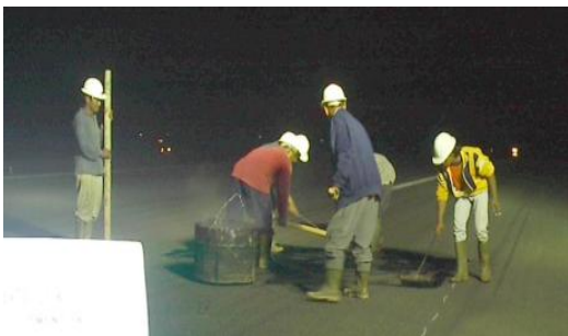
Gambar 13. Tenaga Kerja Yang Bekerja Pada Malam Hari
