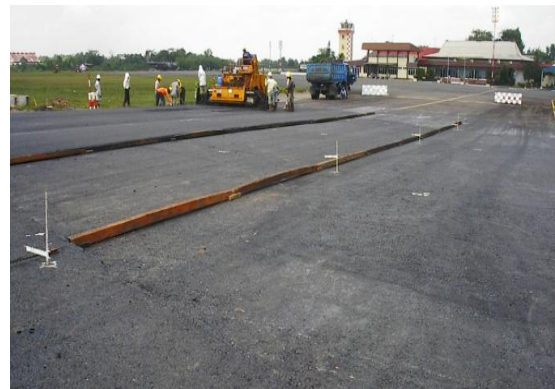
Gambar 8. Pelaksanaan Pekerjaan Perkerasan Taxiway
