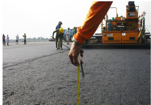
Gambar 10. Pengukuran Ketebalan Penghamparan
