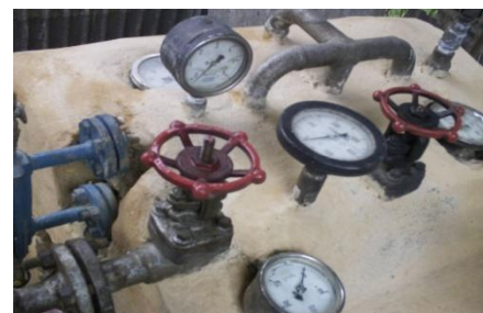
Gambar 4. Steam Drum dan Peralatan Pengukur & Pengendali
