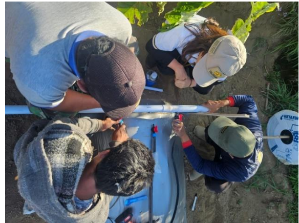
Gambar 7. Instalasi Jaringan Pipa Lateral
