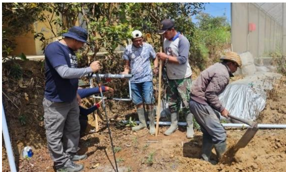
Gambar 5. Instalasi Jaringan Pipa Utama dan Sub Utama
