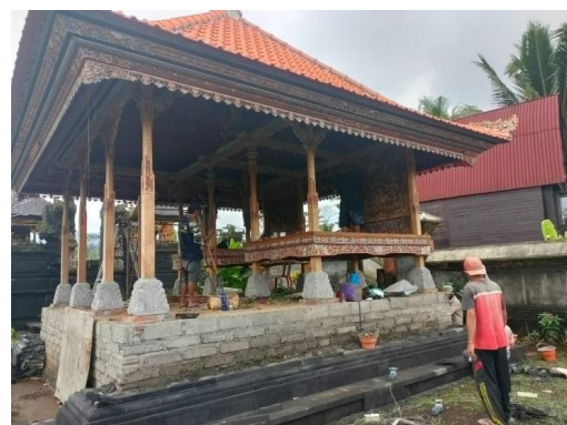
Gambar 2. Pengerjaan Bangunan Tradisional.
