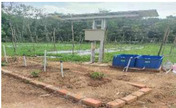
Gambar 7. Hasil Pemasangan Sistem Panel Surya
