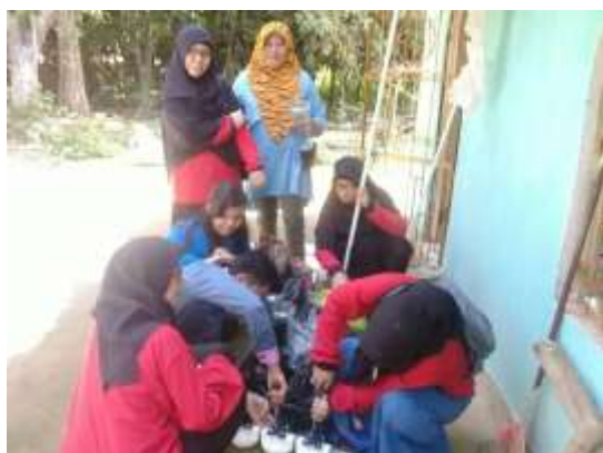
Gambar 5. Proses perangkaian alat instalasi pengolahan air gambut menjadi air bersih
