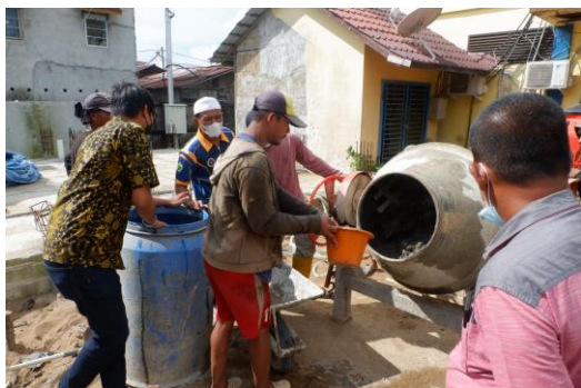
Gambar 4. Kegiatan Pengecoran Struktur Lantai Tempat Wudhu
