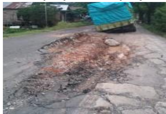
b. Lapisan pondasi yang terlalu tipis
