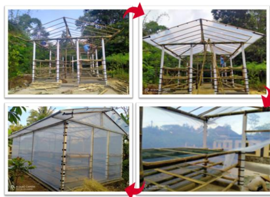
Gambar 4. Pembuatan solar dryer dome
