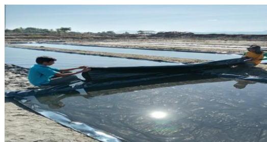
Gambar 5. Pemasangan plastik geomembran
