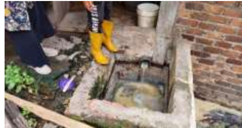
Gambar 9 Limbah cair tahu dalam bak penampung sebelum pengolahan
