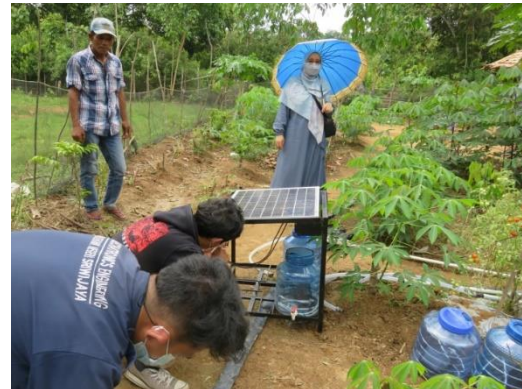
Gambar 3. Pemasangan alat penyiram otomatis tenaga surya oleh mahasiswa anggota penelitian dan pengabdian masyarakat.
