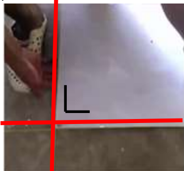
a. Kesikuan keramik dengan benang
