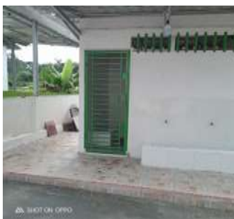
c. Keramik lantai yang telah terpasang
