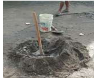
a. Adukan Mortar
