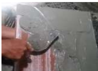
c. Mengoles keramik dgn acian semen
