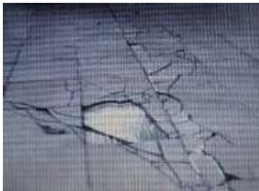
a. Keramik lantai yang terangkat
