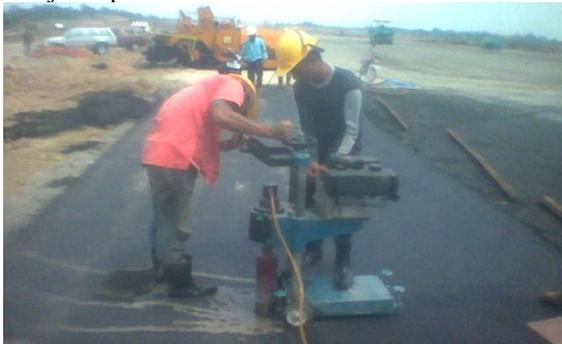
Gambar 11. Pekerjaan Pengambilan Contoh Di Lapangan (Core Drill)
